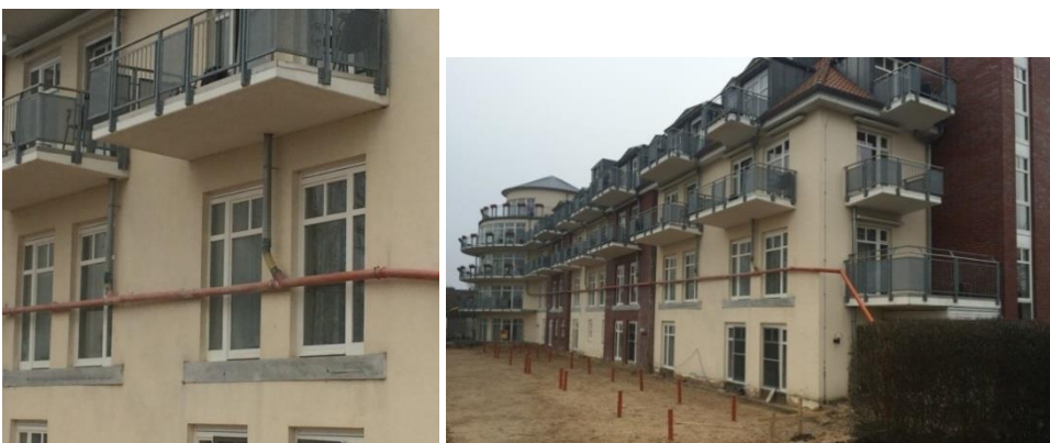
Abb. 32: Wärmebrücken-Rückbau bei bestehenden Balkonen
