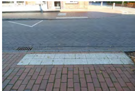
Abbildung 28: Abgesenkte Bordsteine und taktile Elemente (Quelle BIG Städtebau)
