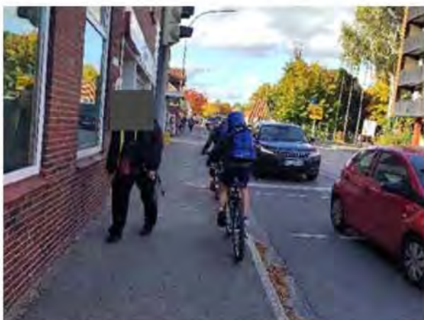
Abbildung 33: Liethberg: Sanierungsbedürftiger Radweg, Quelle: Eigene Darstellung.
