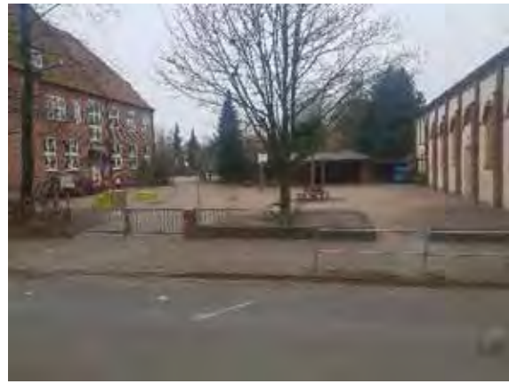
Abbildung 67: Grundschule am Bahnhof. Quelle: Eigene Darstellung.
